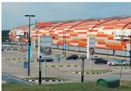
Торговый центр (Москва, 2004)
